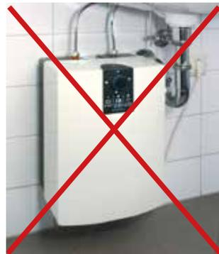
**No instalar detrás de un depósito de baja presión.**
