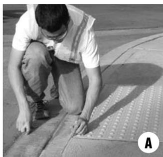
**A.** Con una escoba o un soplador quite toda la basura o tierra en el área donde va a instalar el DWT. Oriente y alinee la teja en el concreto. Marque alrededor del tapete con tinta o pintura y luego levante y quite el tapete (teja).
