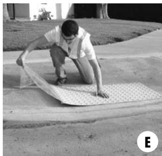
**E.** Quite la película protectora del resto de la teja y desenróllela sobre la superficie ejerciendo presión fuerte para expulsar el aire de debajo del tapete a medida que lo va poniendo en posición. Al instalar tejas DWT Fast adyacentes, deje una separación de aproximadamente 1/8 de pulgada entre ellas.
