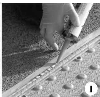
**I.** Use una escoba o un soplador para remover el polvo o sucio de la superficie de la teja DWT Fast. Use el sellante suministrado para formar alrededor del perímetro de la teja en la unión con la superficie, un cordón sellante uniforme. El tapete DWT Fast estará listo para permitir que caminen sobre él en unos 60 minutos.
