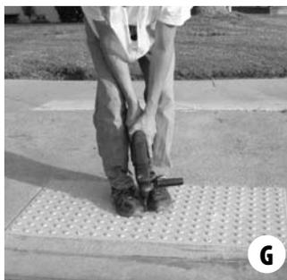
**G.** Use un taladro martillo de impacto con una broca de 1/4 de pulgada y perforo a través de las cúpulas agujeros de 2 pulgadas de profundidad. Soplo el polvo del agujero antes de instalar el ancla para el DWT Fast.
