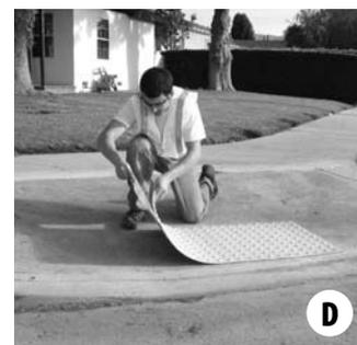
**D.** Alinee la teja o tapete DWT Fast en la posición deseada. Remueva la película protectora del pegante en un extremo de la teja y alinee esa parte de la teja con los extremos del área marcada. Coloque el área expuesta de la teja, la que tiene el pegante, sobre la superficie donde va a instalar la teja. Ejerciendo presión hacia la superficie empuje la teja contra el piso para sacar el aire de debajo del tapete.
