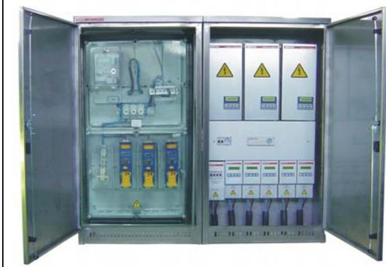
Foto de armario de compañía Sevillana Endesa y Centro de maniobra con regulador de flujo, Sistema de comunicaciones y salidas magnetotérmicas-diferenciales estándar:
