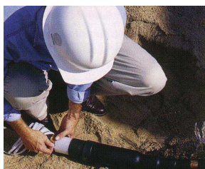
Recupere las tres primeras capas del cable
