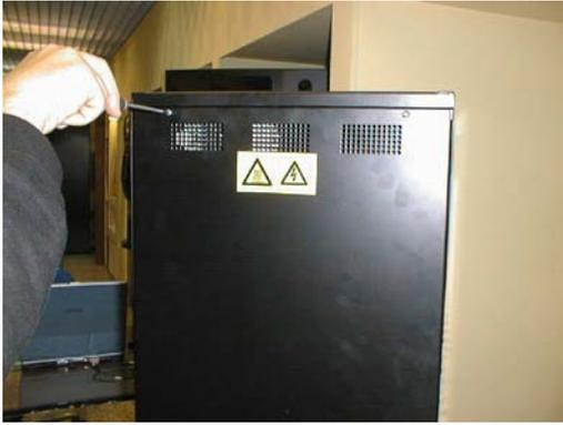
Desmontar la pared posterior del distribuidor XS E extraendo los tornillos de fijación.
