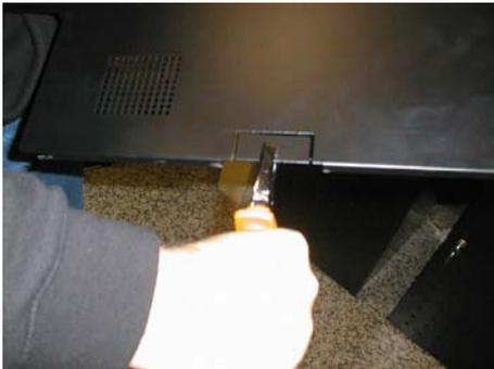
Horadar la pared posterior del distribuidor para enfilear el cable de comunicacion de la Damian Piccola. Montar la pared posterior del distribuidor XS E
