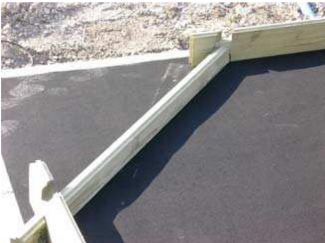
**Verificación de las diagonales:** En el tercer rango instalado, verifique las diagonales de la estructura y ajústelas si es necesario moviendo la estructura.
