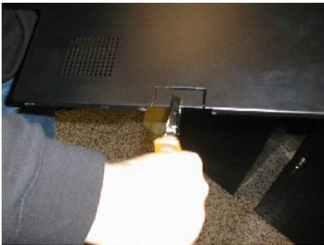
Horadar la pared posterior del distribuidor para pasar el cable de comunicación de la Damian Piccola. Montar la pared posterior del distribuidor XS H - LIONESS.
