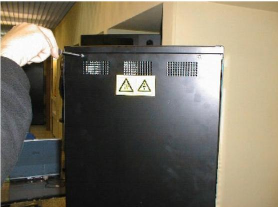
Desmontar la pared posterior del distribuidor XS H - XS H/LIONESS extrayendo los tornillos de fijación.
