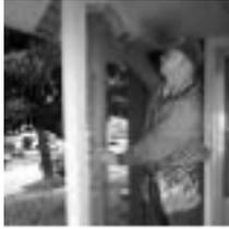
1. Mida la distancia total desde la parte de abajo de la viga hasta la plataforma.
