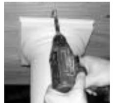
15. Acomode la columna en el lugar de instalación y asegúrela. Asegúrese que el peso esta centrado en el eje de la columna y distribuido de forma pareja. Asegure la columna con soportes tipo "L" en la plataforma y viga.
