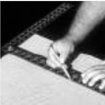
6. Con la ayuda de una regla cuadrada, dibuje una línea perpendicular al borde externo de la plataforma.
