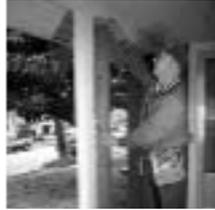
2. Con la ayuda de un poste de madera, una ligeramente la viga al poste para luego removerlo no mas de 1/4 de pulgada.
