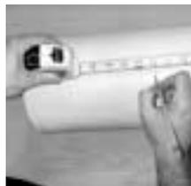
8. Mida desde la punta superior de la columna hasta la altura que necesita, según las medidas del paso #1. Marque la distancia alrededor de la columna para usarla como referencia.
