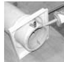
14. Aplique adhesivo de construcción en ambos bordes extremos de la columna.
