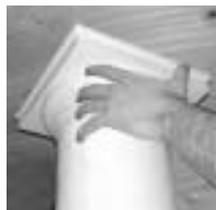
18. Suba el capitel hasta toparlo con la superficie superior y presiónela para asegurarla. Puede usar tornillos para asegurar el capitel a la superficie superior, y la base a la superficie inferior (si usa tornillos, asegúrese de perforar los orificios antes de instalar los tornillos, y rellene con pasta para cubrir los tornillos).
