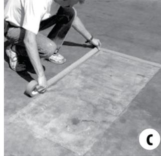
**C.** Después de limpiar la superficie, remueva el polvo o basura con una escoba o un soplador. Ponga cinta pegante de plomero, en la parte de afuera de las líneas marcadas sobre el concreto. Como 1/4 de pulgada por fuera de las líneas.
