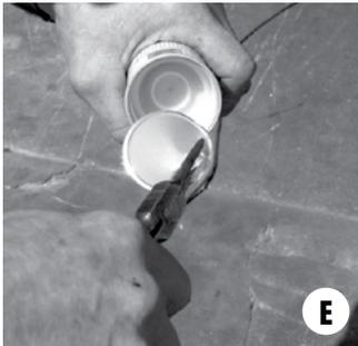
**E.** Si usa el pegante/sellante AdcoSeal Körapur, asegúrese que quita la capa protectora del fondo del cartucho y que saca el desecante antes de cargar el cartucho en la pistola dispensadora del pegante.
