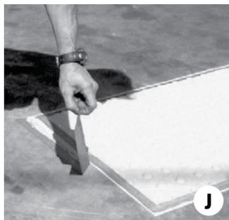
**J.** Inmediatamente quite las cintas adhesivas de plomero de la superficie de la teja DWT-Smart y del concreto. Cualquier adhesivo que quede sobre el tapete DWT puede quitarse con solvente o aguarrás.
