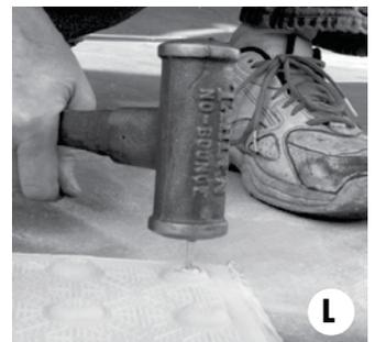
**L.** Siga manteniendo presión sobre el DWT, inserte o meta completamente en el agujero el ancla y golpee suavemente el cuerpo del ancla con un martillo. Al terminar la instalación, el tope del ancla debe estar parejo con el tope de la cúpula moldeada. Tenga cuidado de no apretar demasiado el ancla.
