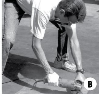
**B.** Es muy importante remover el sucio, agentes de curación del concreto, color, aceite, grasa o cualquier otro contaminante de la superficie marcada, raspándola con un esmeril o cepillo de alambre eléctrico.
