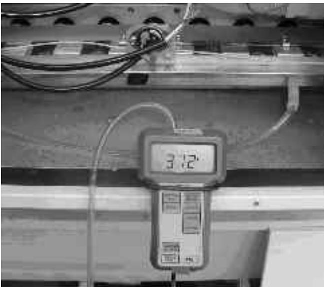
**AJUSTES DE PRESIÓN EN LA VÁLVULA HONEYWELL DE REGULACIÓN DE PRESIÓN TIPO VR 4605P**
