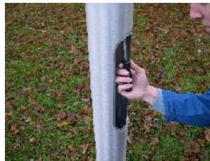
3. Afloje los tres tornillos de cabeza hueca hexagonal (10mm) con un trinquete o herramienta similar.
