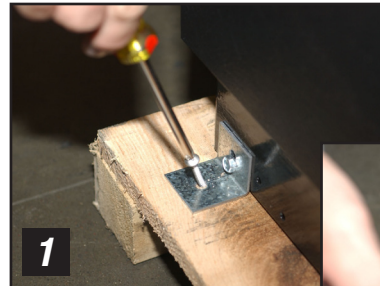
1 Removiendo el soporte de la paleta
