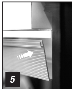
5 Colocando el canal en "U" del protector sobre el soporte de metal.
