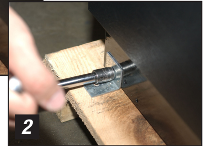
2 Removiendo el soporte del gabinete
