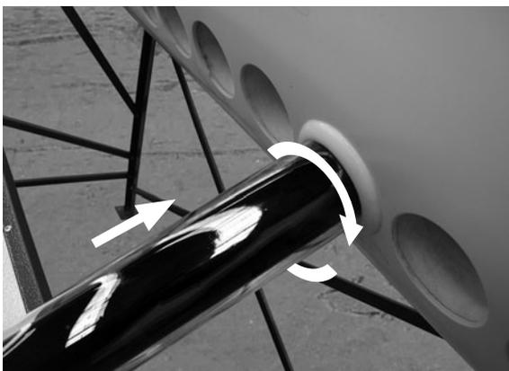
Al insertarlo en la base de tubos debe efectuar el giro para que entre el tubo sin dificultad, evitando así botar y dañar el empaque de silicón interno del termostato.
