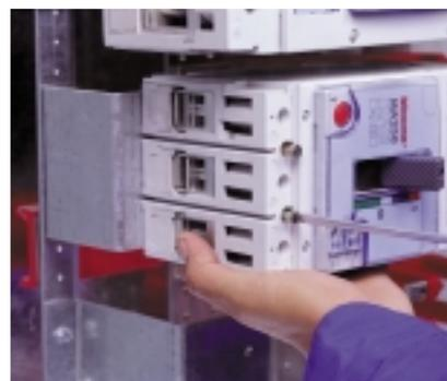
**5** Asegure que el torque en los tornillos de unión a las barras colectoras y en las zapatas de conexión de los interruptores sea el mayor de los valores indicados en la tabla:1:
