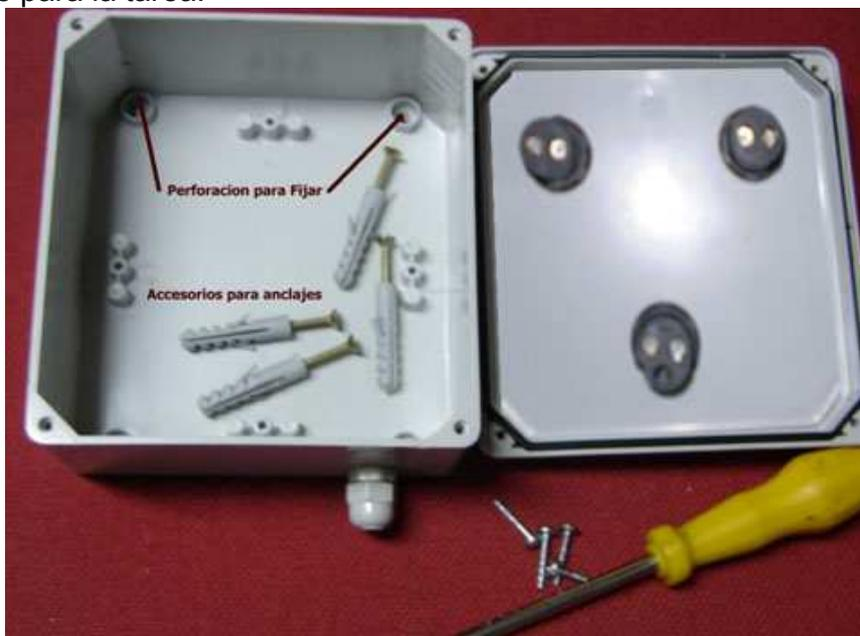
Ya fijado, proceda a aflojar el pasa-cable como muestra la siguiente figura:
