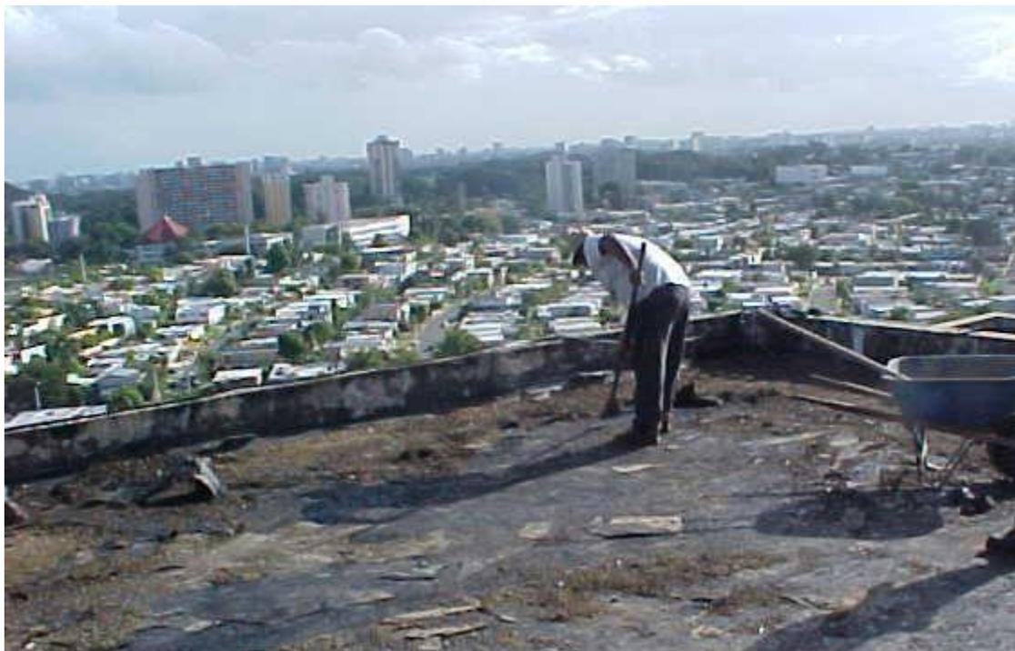
2. Raspe toda la superficie con pala de corte para eliminar asperezas y deformidades. Limpie con cepillo de nylon y lave todo el techo con máquina a presión.
