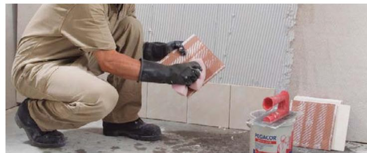
**4)** Utilice la llana dentada del tamaño adecuado, de acuerdo al tamaño del revestimiento para aplicar el pegante en el soporte.
