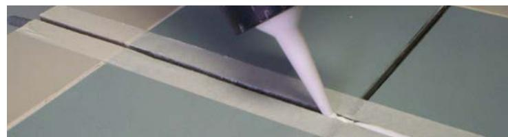
6) Haciendo presión con una espátula plástica sobre la junta, pula la aplicación y retire los excesos de SILICONA CONSTRUCCIÓN.
