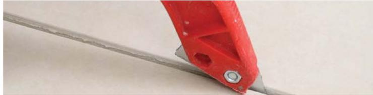
2) Seleccione el concolor® de acuerdo al ancho de la junta: de 1 a 5 mm: concolor® junta estrecha de 5 a 15 mm: concolor® junta ancha.
