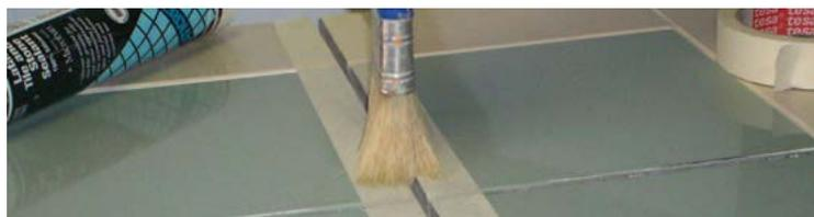
3) Introduzca en la junta un cordón de Sellalón® de la mitad del ancho de la junta pero no menos de 5mm.
