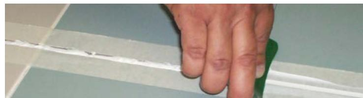
7) Una vez aplicada la SILICONA CONSTRUCCIÓN espere 24 horas para retirar la cinta. Retire la cinta en diagonal hacia atrás.
