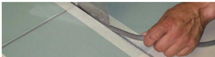
4) Para facilitar la aplicación de la SILICONA CONSTRUCCIÓN, corte la boquilla al ancho de la junta que va a rellenar.
