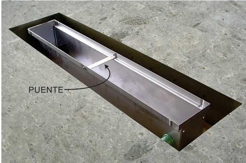
Coloque y oriente la Carcasa de Montaje en un hueco según las dimensiones de la hoja anterior.
