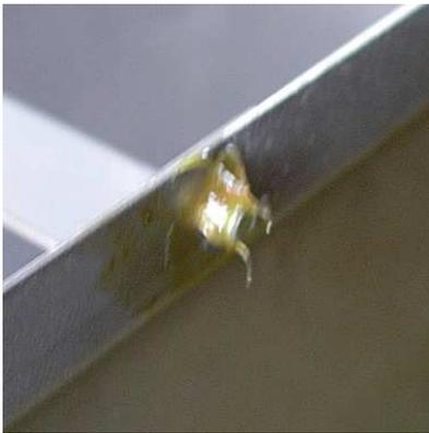
Unte un poco de Manteca o algún desmoldante en la rosca que sobresale hacia afuera de la Carcasa, en la sujeción de los "Puentes". Esto es para facilitar el desmontar los "Puentes", una vez fraguado el Concreto.
