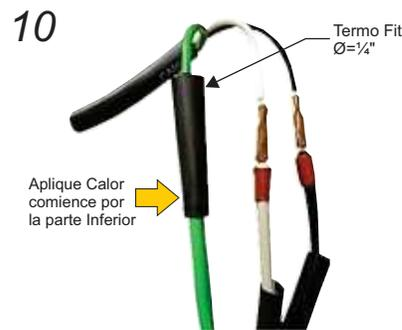
Coloque el Termo Fit Centrado al Área de Conexión. Es Importante que el Termo Fit cubra perfectamente TODA la conexión.
