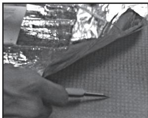
**7** Dado que o cabo de alimentação é ligeiramente mais espesso que a rede radiante, é necessário fazer uma pequena ranhura na placa de isolamento no local onde o cabo de ligação passa.
