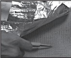
**7** Dado que el conector es ligeramente más alto que el resto de la red, haga un pequeño canal en la plancha de aislamiento para introducir el conector y evitar que la red se arrugue. Asimismo, haga una canal para las conexiones frías en el punto en el que éstas se crucen.
