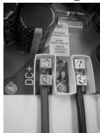
Figure 3.6.1 : Cheminement des câbles DC
