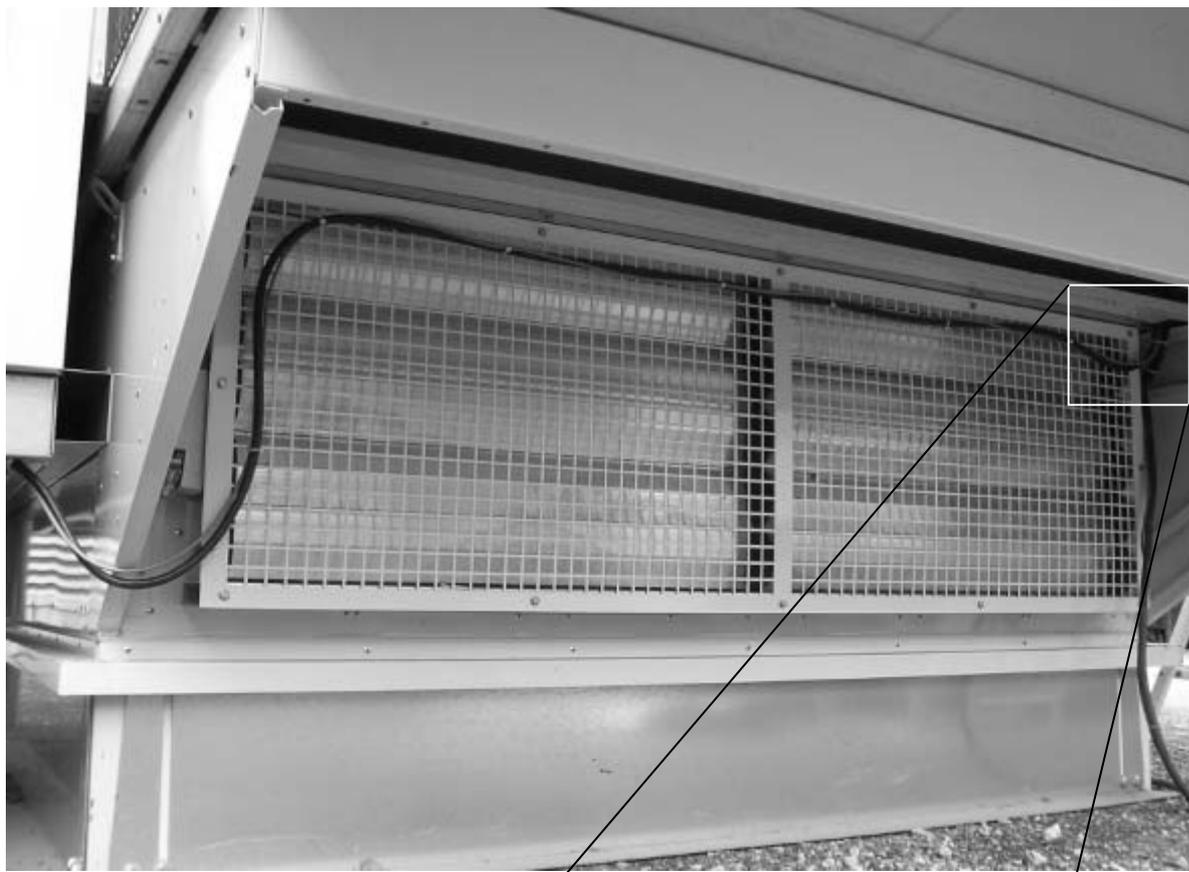
Cables desde el módulo hasta el panel eléctrico de la unidad rooftop a través del orificio
