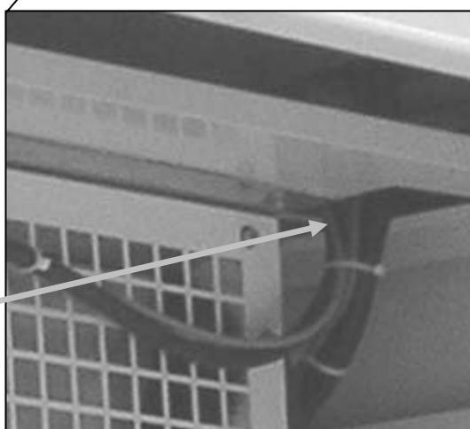
Después conecte el cable de alimentación desde el módulo a la unidad rooftop, y el t-lan al Climatic50 (o el BE50 si lo hay en el panel eléctrico de la unidad rooftop)
