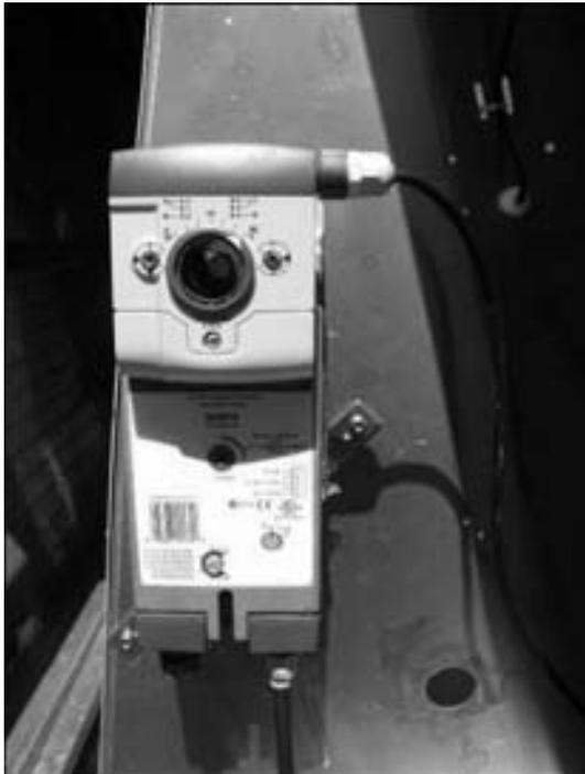
Un interruptor auxiliar permite establecer un mínimo (escaso %) de apertura de aire de retorno antes de conectar el ventilador.
