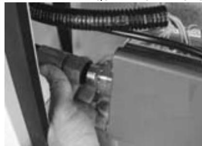
Purgue durante unos segundos la tubería situada cerca de la conexión en la válvula de control de encendido.
