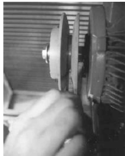
La resistencia real de los sistemas de tuberías no siempre coincide con los valores teóricos calculados. Para rectificarlo, puede que sea necesario modificar el ajuste de la polea y la correa; para ello los motores disponen de poleas variables.
