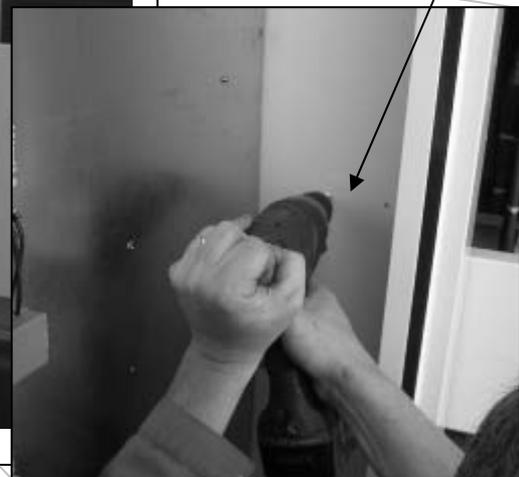
Y fije la parte superior del módulo a la unidad rooftop utilizando tornillos auto perforantes de 19 mm
