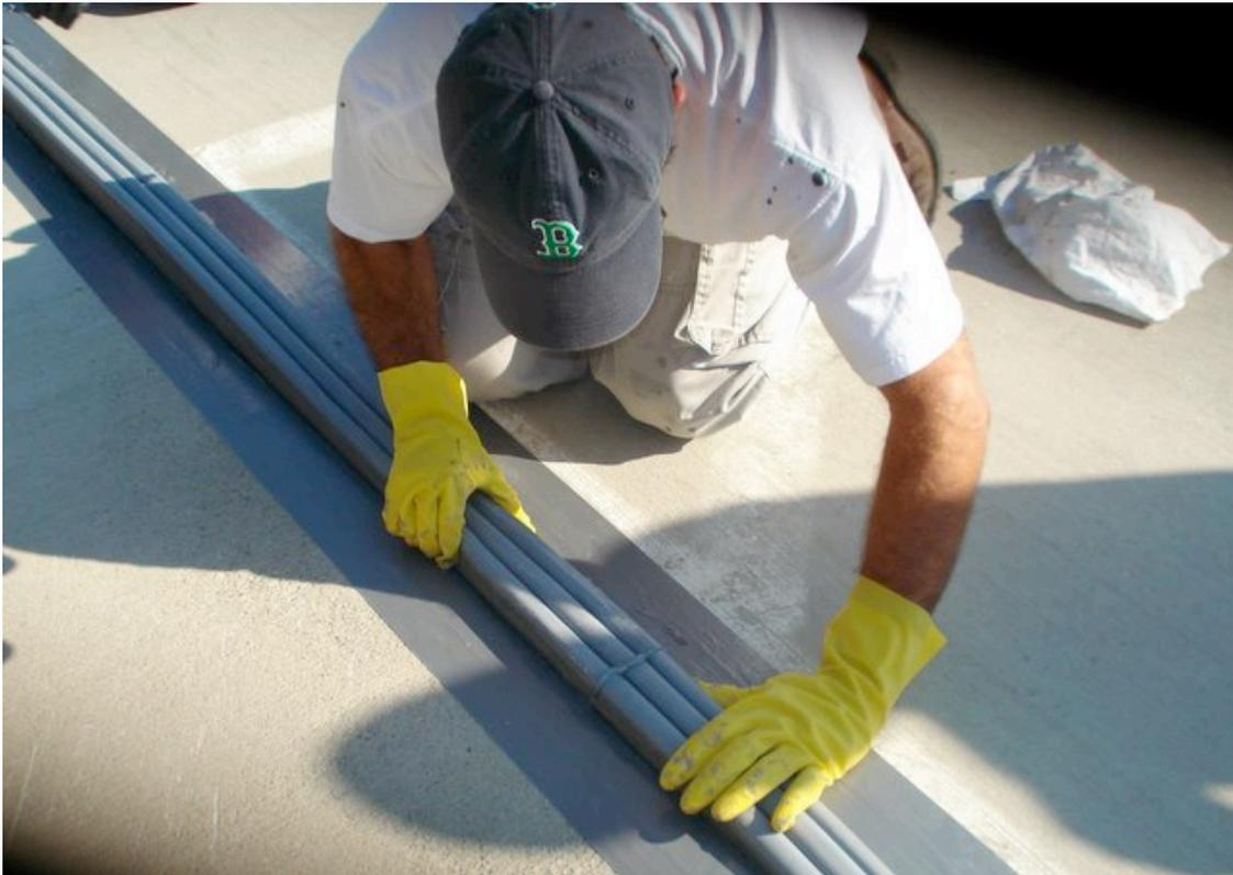
Cuando lo tengamos colocado retiraremos la resina epoxi restante y pasaremos a usar nuevamente la pistola de aplicación de silicona para los bordes. Homogeneizamos la zona con un dedo y retiramos el sobrante.
