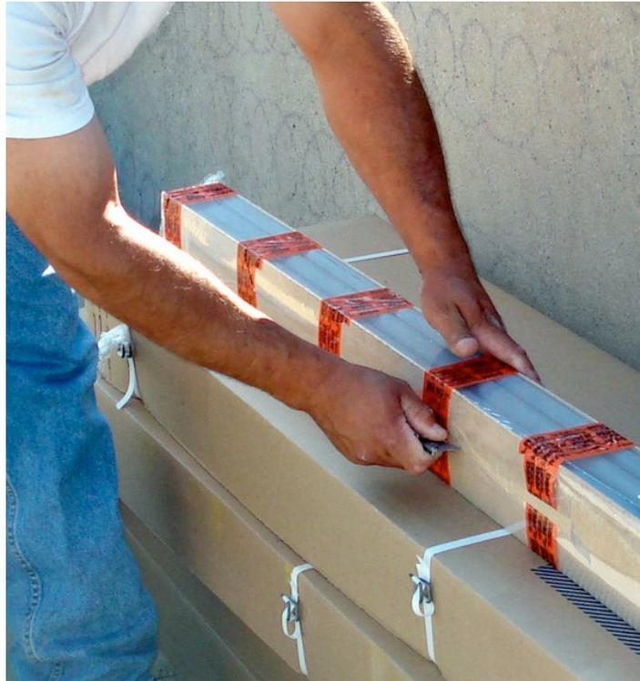
Se aplica una resina epoxi a las 3/4 partes inferiores de la superficie del producto para que se pueda adherir a las paredes laterales de la junta.
