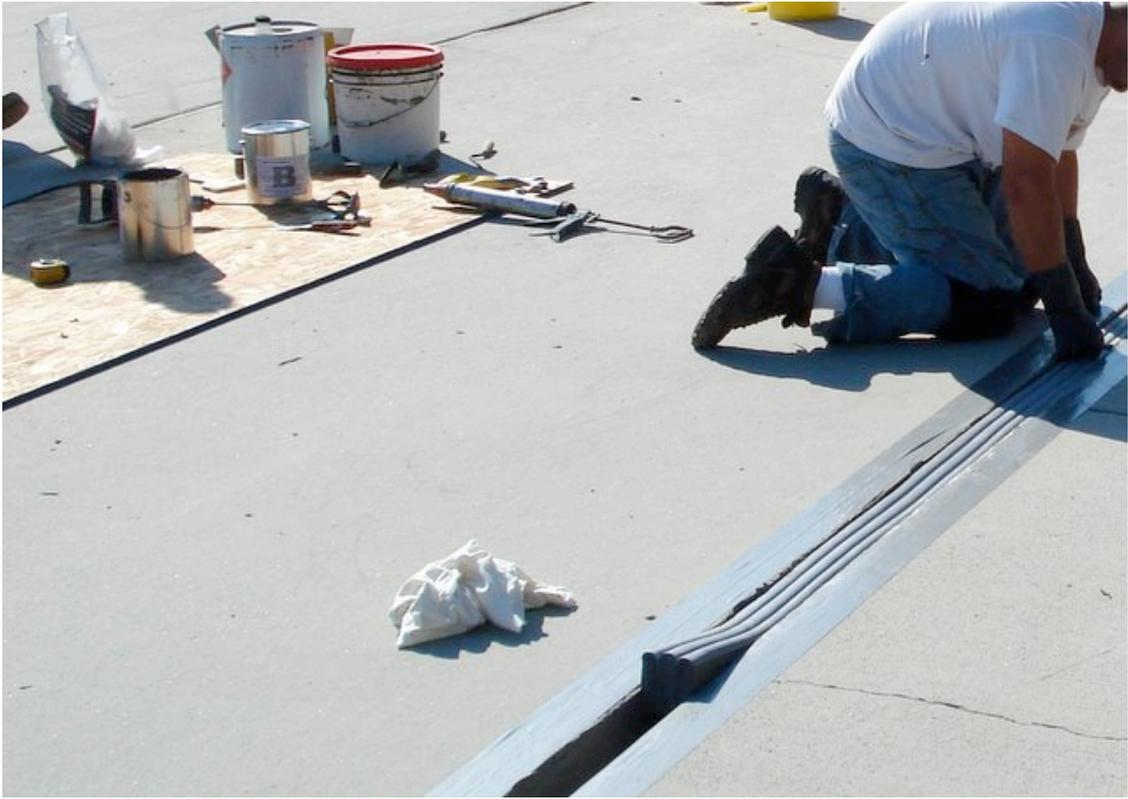
Usando la pistola de aplicación que acompaña al sistema, se aplicará el producto (una especie de silicona) por la parte frontal del sistema para que pueda unirse a las otras partes del mismo. Es importante que se aplique justo como se muestra en la imagen (solo la parte superior frontal).
