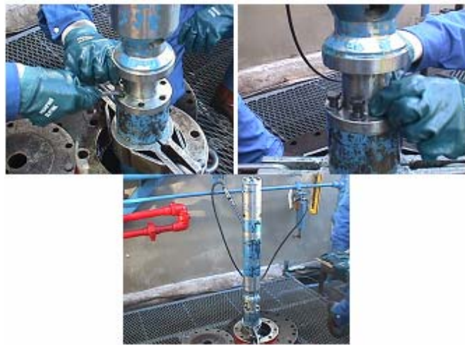
Figura No. 70 Colocando Tornillos Hexagonales y arandelas de Presión
