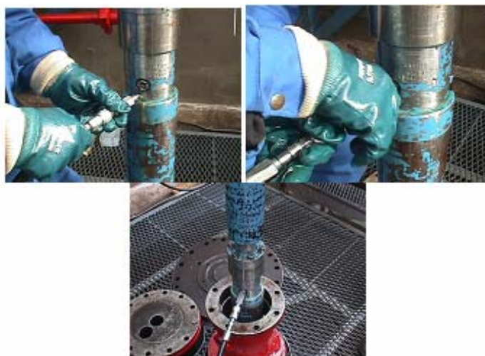
Figura No. 52 Conectando Manguera Para Llenado de Aceite.
