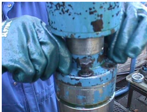
Figura No. 75 Colocando Tornillos Hexagonales y Arandelas de Presión
