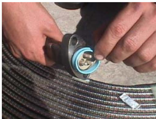
Figura No. 84 Pothead Construidos en Dos Piezas
