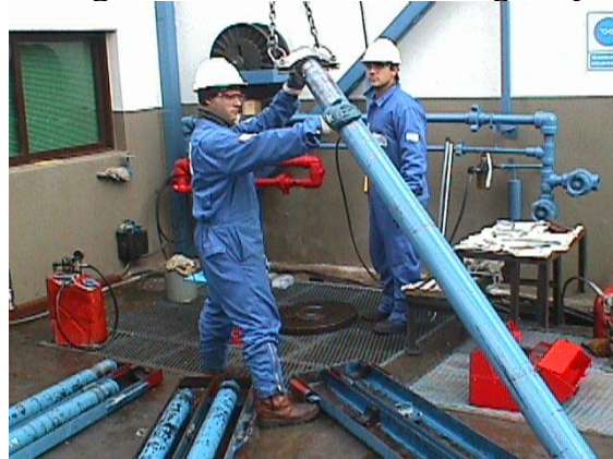
Figura No. 31 Enganchando la cadena de la grampa con la grúa.
