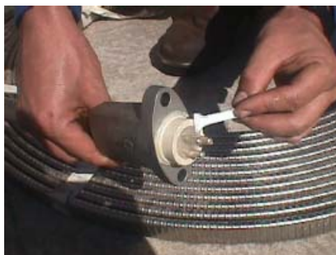
Figura No. 86. Pothead moldeado en una pieza
