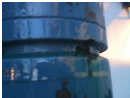
Figura No. 65 Orificio de Construcción de Guía Superior
