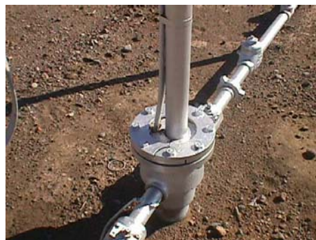
Figura No. 90 Cabezal de Boca de Pozo
