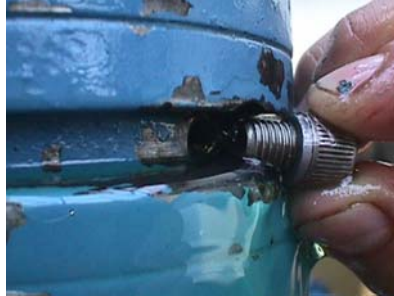
Figura No. 57 Instalando Tapón con Junta de Plomo
