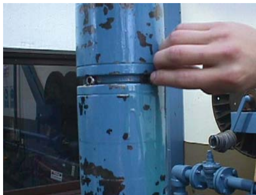
Figura No. 55 Instalando Tapón
