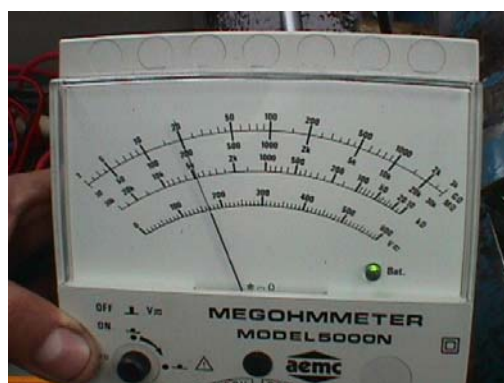
Figura No. 15 Medición 200 mega ohms (motor con problemas de aislación)
