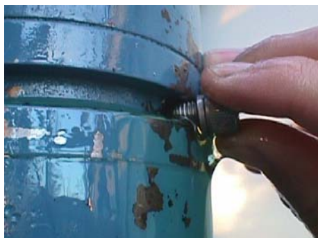
Figura No. 67 Retirando Tapón Temporario
