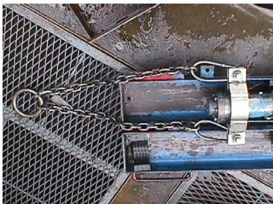
Figura No. 30 Colocando Grampas de Elevación en los Equipos
