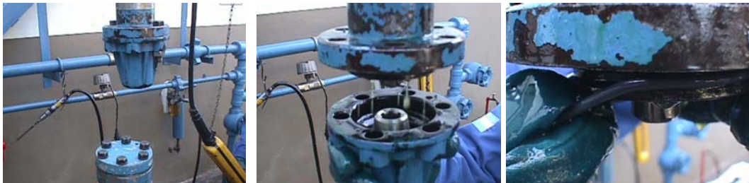
Figura No. 73 Retirando Tapa de Protección de Bomba-Separador
