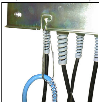
Fig. 33 Descarga de tracción
