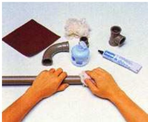
Para untar el ADHESIVO, debe usarse una brocha de un ancho aproximado de la mitad ( $\frac{1}{2}$ ), del diámetro del tubo que se está pegando. Esta es la medida adecuada para lograr una buena distribución del ADHESIVO.
