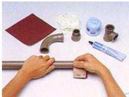
Unta el ADHESIVO sobre el extremo del tubo y en el accesorio. Coloca el accesorio en el tubo, lo gira  $\frac{1}{4}$  de vuelta, lo ajusta en la posición deseada y lo sostiene durante 15 segundos.
