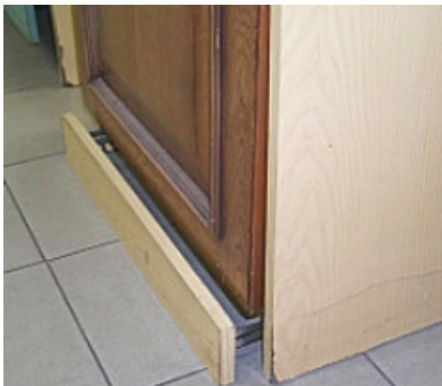
La alineación se obtiene haciendo presión sobre el zócalo ya que las grapas en “L” ofrecen resistencia al desplazamiento.
