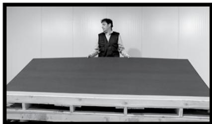
**Fig.1** - Las placas de 300x100 cm de KERLITE y KERLITE PLUS pueden ser levantadas por una persona. Para levantar una placa, es necesario hacerlo lentamente por el lado más largo, eliminando de esta manera el efecto ventosa debido a la adherencia con la placa subyacente y permitiendo una buena toma con las manos.
