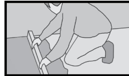
**Fig.48** - Para las losas de cemento, el período de maduración es uno de los principales requisitos. El tiempo de maduración de una losa tradicional de arena y cemento es aproximadamente 7-10 días por centímetro de espesor. Para las losas premezcladas, como **Topcem Pronto** de Mapei o **Keracem Eco Pronto** de Kerakoll, seguir las indicaciones del fabricante.
