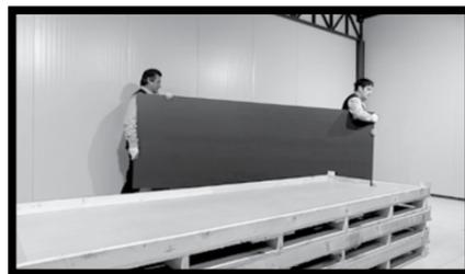
**Fig.3** - Levantar la placa en posición vertical sosteniéndola por el borde superior y desplazarse manteniéndola siempre rectilínea con la ayuda de otra persona.
