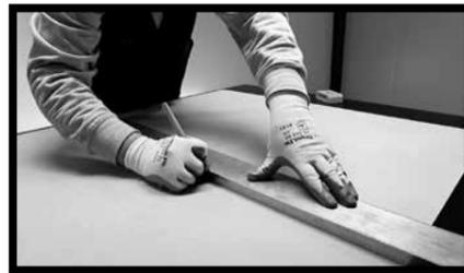
**Fig.10** - Para que la incisión resulte lo más rectilínea posible se pueden utilizar las miras de aluminio que comúnmente utilizan los albañiles.
