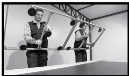
**Fig.4/5** - Todos los tipos de placas de KERLITE formato 300x100 cm pueden ser desplazados por dos personas con el auxilio de un chasis específico. Fijar el chasis a la placa mientras ésta se encuentre todavía en el palet. Luego levantar el chasis y la placa para eliminar el efecto ventosa.
