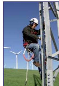
Ejemplo: trabajo con línea rígida en vertical
