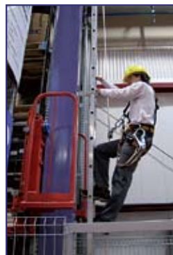
Ejemplo: trabajo con línea flexible en vertical
