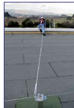
Ejemplo: trabajo con línea flexible en horizontal
