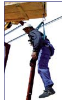
Ejemplo: Caída y posterior suspensión de un trabajador
