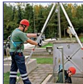
Ejemplo: trabajo en espacios confinados con bloque retráctil con rescatador
