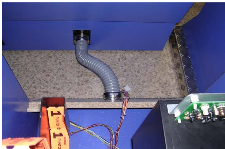
Figura 5: así deben quedar conectados los tubos corrugados.
