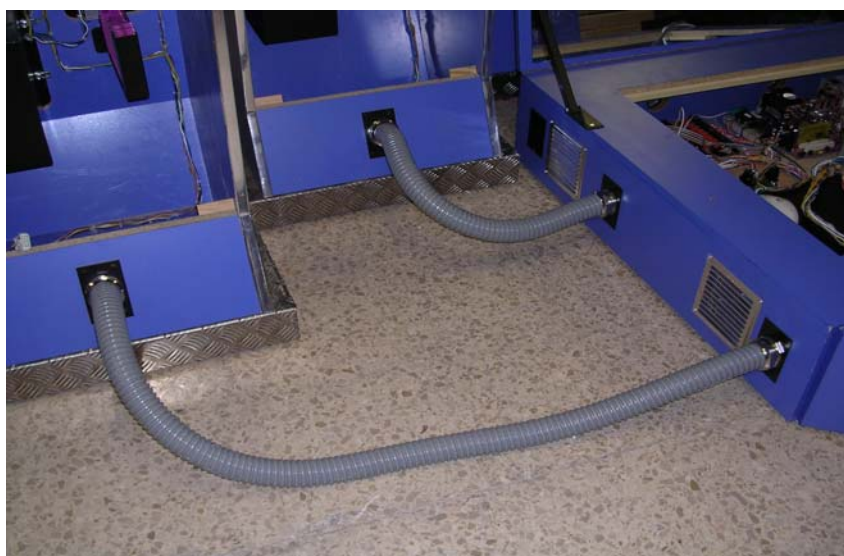
Figura 6: así deben quedar conectados los tubos corrugados
