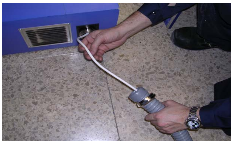
Figura 3: controlar que conexión a placa de servicio este correctamente conectada y luego pasar su correspondiente cable de conexión a través tubo corrugado. Figura 4
