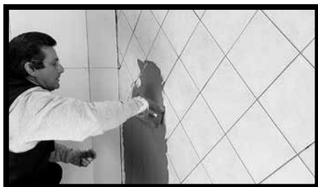
Fig.61 - Colocación en pared
