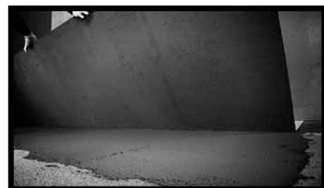
Fig.68 - 2 - Se deben colocar apoyando uno de los lados largos, y luego acompañándolas al suelo.
