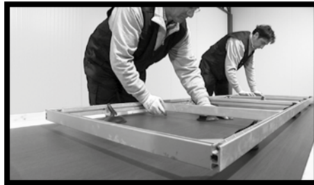
Fig.4/5 - Todos los tipos de placas de KERLITE formato 300x100 cm pueden ser desplazados por dos personas con el auxilio de un chasis específico. Fijar el bastidor a la baldosa mientras ésta se encuentre todavía en el palet. Luego levantar el bastidor y la baldosa para eliminar el efecto ventosa.
