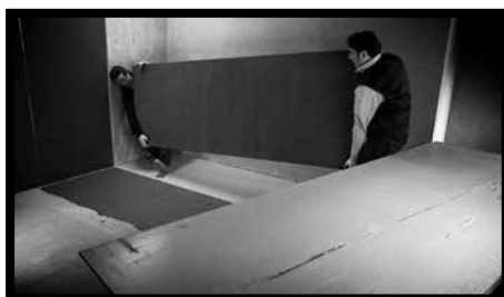
Fig.67 - 1 - Desplazar las placas manteniéndolas siempre en posición vertical, sosteniéndolas por el canto superior, con la ayuda de una segunda persona.
