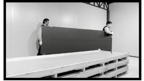
Fig.3 - Levantar la placa en posición vertical sosteniéndola por el canto superior y desplazarse manteniéndola siempre rectilínea con la ayuda de otra persona.
