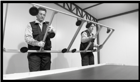
Fig.4/5 - Todos los tipos de placas de KERLITE formato 300x100 cm pueden ser desplazados por dos personas con el auxilio de un chasis específico. Fijar el bastidor a la baldosa mientras ésta se encuentre todavía en el palet. Luego levantar el bastidor y la baldosa para eliminar el efecto ventosa.
