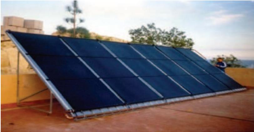
Los paneles Solapool son fácilmente montador en cualquier tipo de ubicación con la ayuda de planchas galvanizadas, se colocan sobre estas para evitar fuerzas de pandeo y tracción evitando así su deformación a largo plazo, además esto nos permite protegerlo de superficies rugosas.
