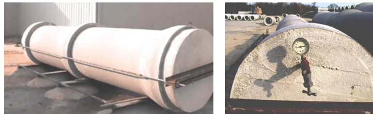
Fig. 3.16 Ensamble y medición de la prueba hidrostática
