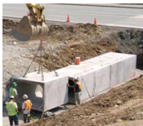
Fig. 3.4 Sistema de alcantarillas de cuadro
