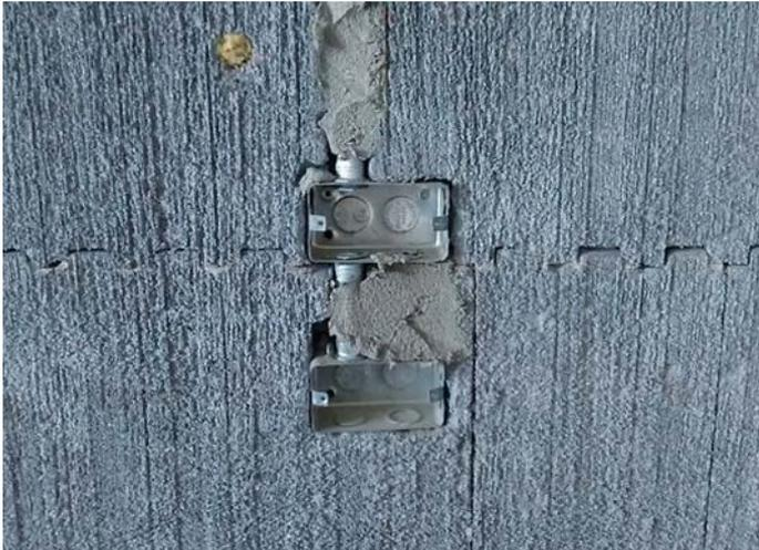
Fijación de cañería y cajas con mortero.
