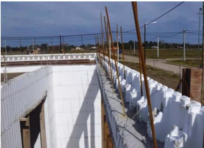
Utilizar la cara exterior del ladrillo como rebalse de losa.
