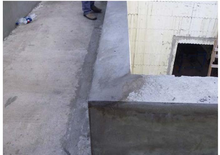
Es posible utilizar cupertinas Isolbrick, ya que aportan la pendiente necesaria para que el agua pueda escurrir libremente. Es importante asegurar la continuidad de la impermeabilización para evitar filtraciones.
