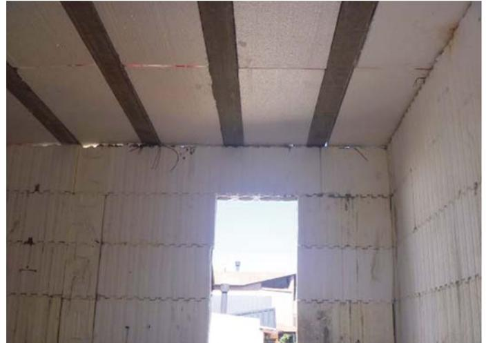
La estructura de la losa debe descansar sobre el hormigón de los tabiques.
