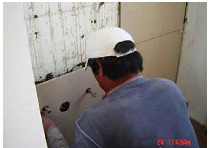
Revestimientos cerámicos colocados con adhesivo cementicio flexible para piezas de baja absorción.
