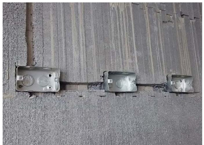
Colocación de cajas de electricidad en el espesor del EPS/Neotech.
