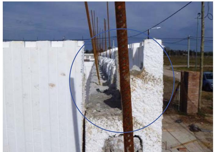
Punto de apoyo de las viguetas o estructura de la losa para entrepisos.
