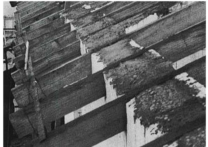
Fig. 12 • Encastrar las vigas de madera al Isolbrick.
