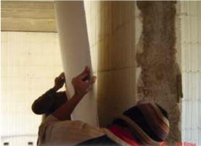
Emplacado con placas de roca de yeso. Utilizar adhesivo recomendado por el fabricante.
