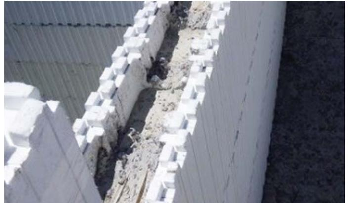
aún fresco, chequear los plomos. En el caso de armar por etapas, una vez lleno el primer tramo de 3 hiladas, se recortan los sectores de ladrillos correspondientes a los vanos de puertas y ventanas y se continua con el armado de muros, generando a partir de aquí los vanos de puertas y ventanas, e incorporando en cada terminal las tapas para evitar la pérdida de hormigón en estos sectores.
