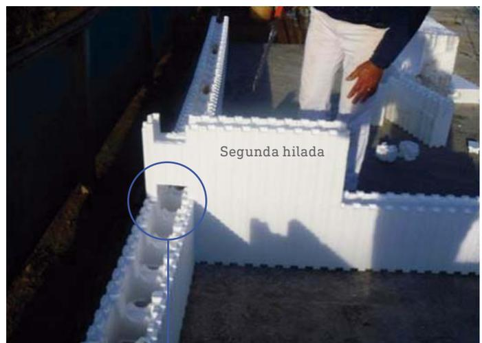
Corte del ladrillo para dar continuidad al hormigón
