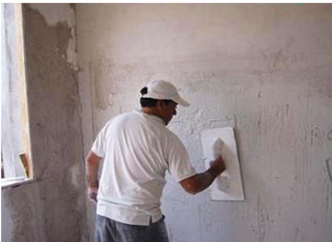
Yeso monocapa (proyectable/manual). Espesor 1,5 cm.
