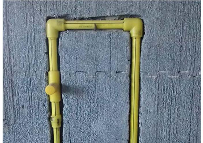
Colocación de cañerías en el espesor del EPS/Neotech.
