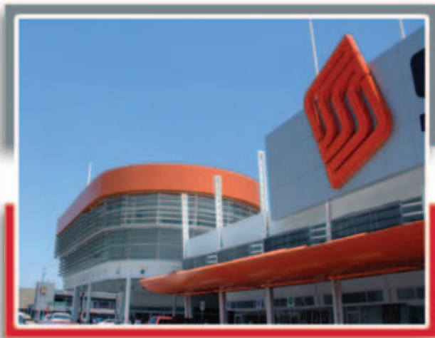
Proyecto: Soriana Ubicación: Monterrey, N.L. 2004
