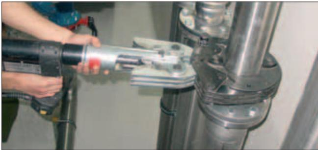
Básicamente, el procedimiento es similar a las medidas inferiores, únicamente cambia la máquina de prensar y el concepto de mordaza, que para estos diámetros es del tipo cadena.
