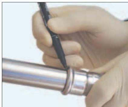
Hacer una marca para posteriormente asegurar el prensado
