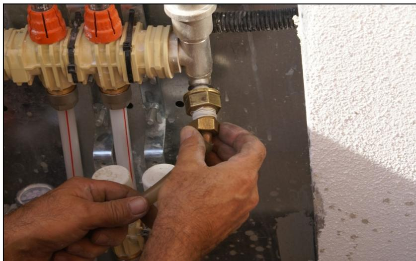
*Colocación goma desagüe agua en colector modular*
