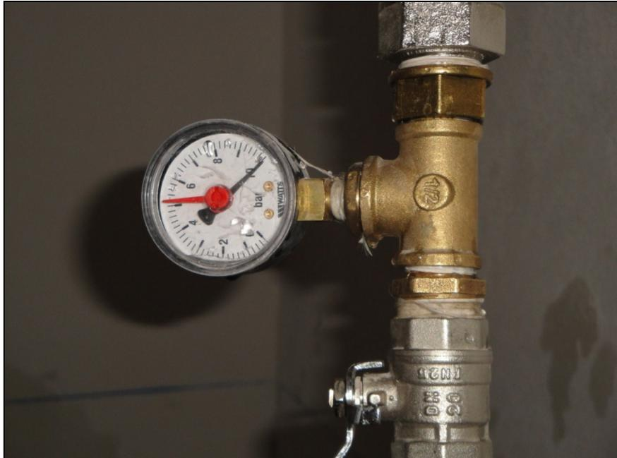
*Presión de prueba sistema plomyFLOOR (10 kg/cm<sup>2</sup>)*
