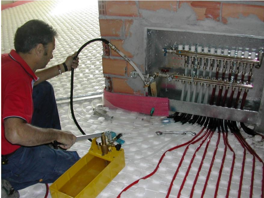
La Norma UNE-EN 1264-4, indica que en el caso de que el mortero incluya cemento con aditivo, la puesta en marcha de la instalación debe efectuarse transcurridos al menos 21 días desde la colocación del mortero. En la puesta en marcha de la instalación no se deben superar los 20 y 25°C de temperatura de impulsión y mantenerse al menos por 3 días. Posteriormente se mantendrá la temperatura máxima de proyecto, al menos otros 4 días.
