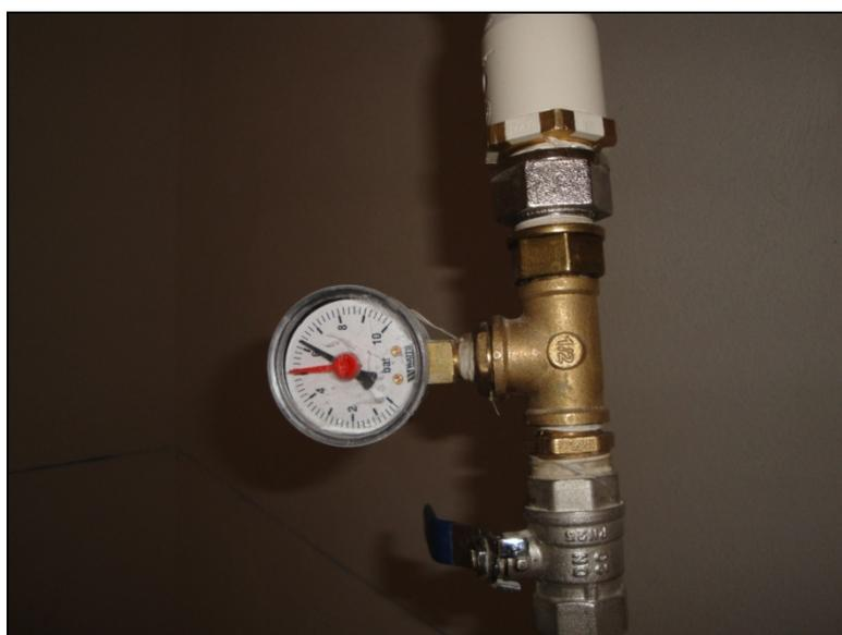
*Presión de prueba sistema plomyFLOOR (0,6 kg/cm<sup>2</sup>)*
