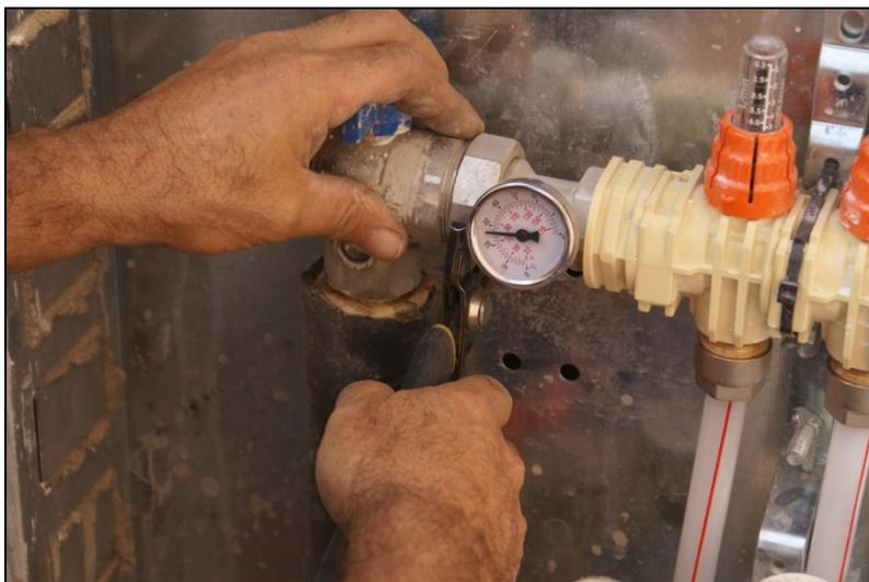
*Ajuste y apriete de uniones roscadas en colector plomyFLOOR*
