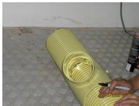
Retire la silla e inicie la perforación de la marcación realizada al tubo.
