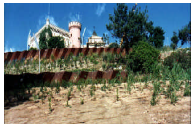
6. Taludes Castillo de Castelldefels (Barcelona)
