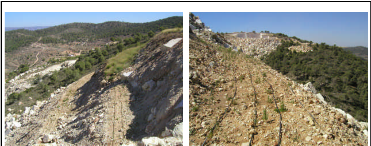
1. Fase inicial: instalación de PORITEX
