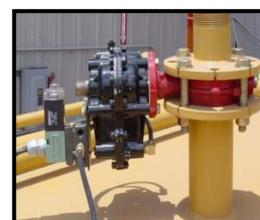
Es una válvula electroneumática que regula el flujo de agua que llega al sistema lanza agua. Un solenoide de 24 V CC recibe la orden del interruptor de control del
