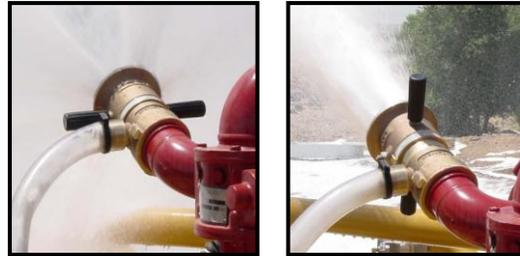
**Niebla/chorro:** es una boquilla con cavidad recta modificada que brinda al operador la posibilidad de ajustar manualmente los patrones de chorro de agua seleccionados entre niebla y chorro. Algunas boquillas están preparadas para la educción de espuma para extinción de incendios.
