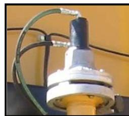
Es un cuerpo de válvula de aluminio de dos piezas, un cilindro hidráulico y un anillo ajustable montados en el tubo colector de un suministro de agua. La
