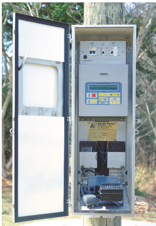
Gabinete de Control y Comunicaciones de Montaje en Poste
