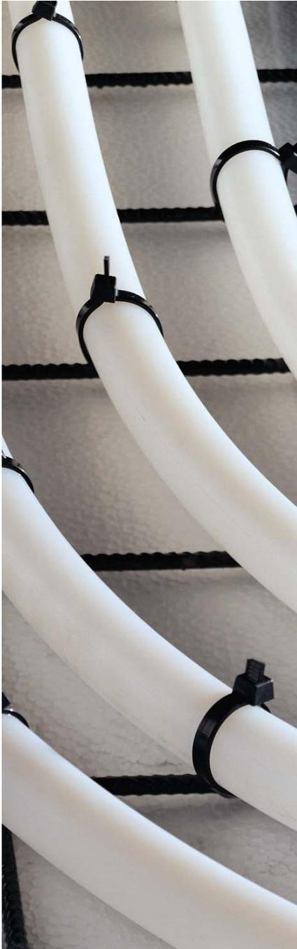
**PLATEAU PEX** - piso Radiante, un sistema de calefacción cuya instalación, a diferencia de la antigua Losa Radiante, se realiza dentro del contrapiso y sin estar en contacto con la estructura de la losa. **Permite dirigir el calor en la dirección del local elegido**, evitando calefaccionar viviendas vecinas y gastos excesivos de energía.
