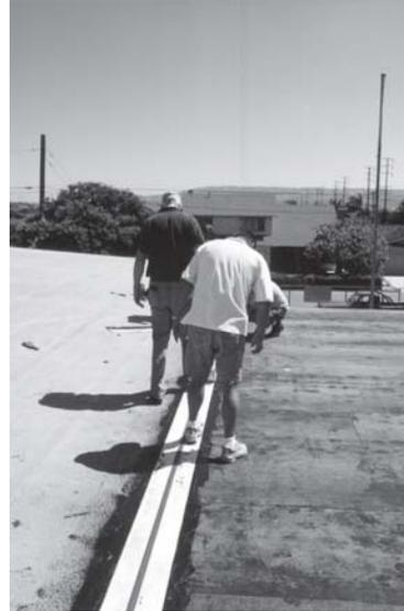
↑ *Se aplica presión sobre el RedLINE para que la lanilla se incorpore completamente en el adhesivo.*
