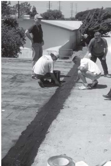
← *Una base de adhesivo frío se aplica sobre la superficie preparada para tender el RedLINE.*
