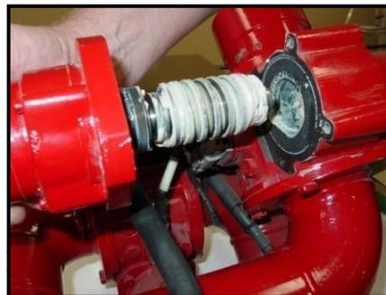
5. Gire la junta para detectar cualquier indicio de filtración de agua.
