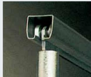
El sistema de guía de acero galvanizado y odines de desplazamiento abren y cierran la barrera fácilmente.
