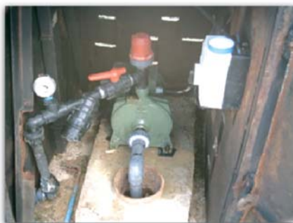
b. Cabezal de riego con motobomba.
