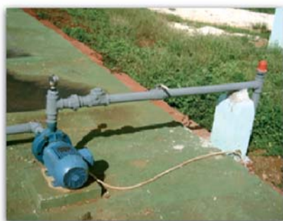
Fig. 66. a.. Motobomba eléctrica sin protección, b. Motobomba eléctrica protegida.
