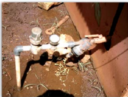
Fig. 64. a. Cabezales de riego,
