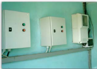
Fig. 65. Cajas con mecanismos eléctricos de protección.
