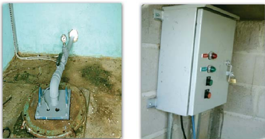
Fig.67. Motobomba sumergible con caseta, válvula de retención, manómetro, válvula de control y panel de control.
