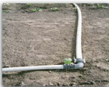
Fig. 59. a. Utilización del codo 90° y b. Protección de los laterales.
