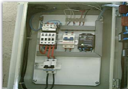
Fig. 65. Cajas con mecanismos eléctricos de protección.
