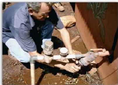
Fig. 63. Limpieza de los filtros.
