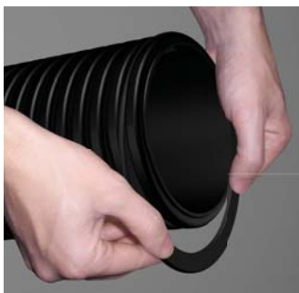
(e) Estire un poco el aro de modo de posibilitar el encastre completo sin que el mismo quede mordido.
