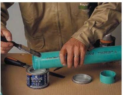
**4.** Aplique generosamente soldadura líquida al exterior del extremo del tubo, por lo menos de un largo igual al de la campana del accesorio.
