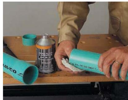
**3.** Limpie bien las superficies que se van a conectar tanto del tubo como del accesorio, con un trapo limpio humedecido con el Limpiador Removedor PAVCO.
