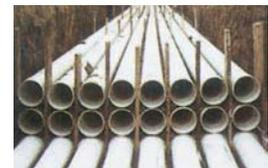
Ducto DB o TDP instalado directamente en el terreno
