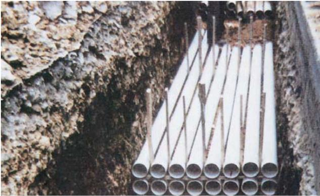
Los Ductos Telefónicos y Eléctricos PAVCO se fabrican bajo los antecedentes de la Norma Nema TC-6 y cumplen con todos los requisitos exigidos por la Norma Técnica Colombiana 1630 y 3363. Los Ductos PAVCO están garantizados para la conducción de cables de potencia cuya temperatura en el conductor sea de 90°C.
