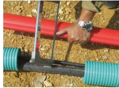
Corte el tramo de reparaducto para la sección dañada
