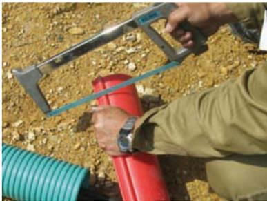
3. Corte 3 cms del ensamble mecánico a los extremos de la sección de reparaducto
