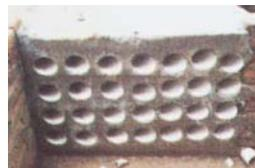
Ducto EB revestido en concreto
