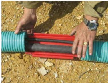
4. Coloque la sección media inferior alojando los cables
