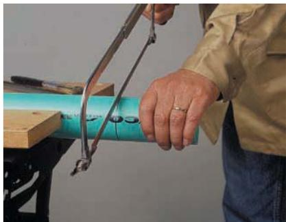
**1.** Corte el tubo con una segueta. Asegúrese que el corte esté en escuadra usando una caja guía.
