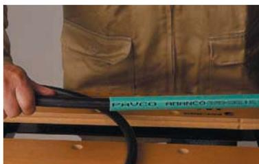
El primer paso consiste en insertar el caucho para doblado dentro del Conduit PAVCO. Asegúrese de usar el caucho de diámetro correcto. El caucho debe entrar ajustado. el tubo se calienta más eficazmente insertándolo en un tubo de acero de diámetro mayor, colocando sobre una mesa formando un hornillo y girándolo continuamente.
