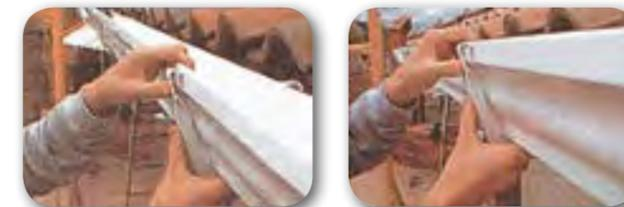
Por último acople la Tapa Interna si es un accesorio y acople la Tapa Externa si es extremo de Canal.
