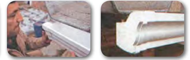
Es la que se hace cuando la canal requiere ser suspendida de la teja, bien porque ésta sobresale mucho de la fachada, o porque el muro es irregular y no permite alinear bien los soportes.
