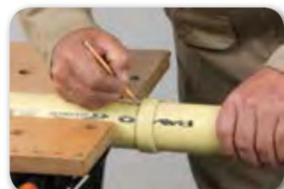
1. Corte el tubo con una següeta. Asegúrese que el corte esté a escuadra usando una caja guía.
