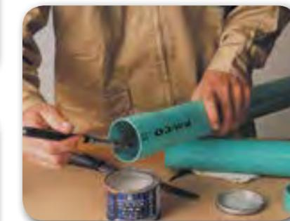
6. Una el tubo con el accesorio asegurándose de un buen asentamiento y déle un cuarto de vuelta para distribuir la soldadura, mantenga firmemente la unión por 30 segundos.
