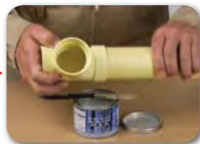
6. Una el tubo con el accesorio asegurándose de un buen asentamiento y déle un cuarto de vuelta para distribuir la soldadura, mantenga firmemente la unión por 30 segundos.
