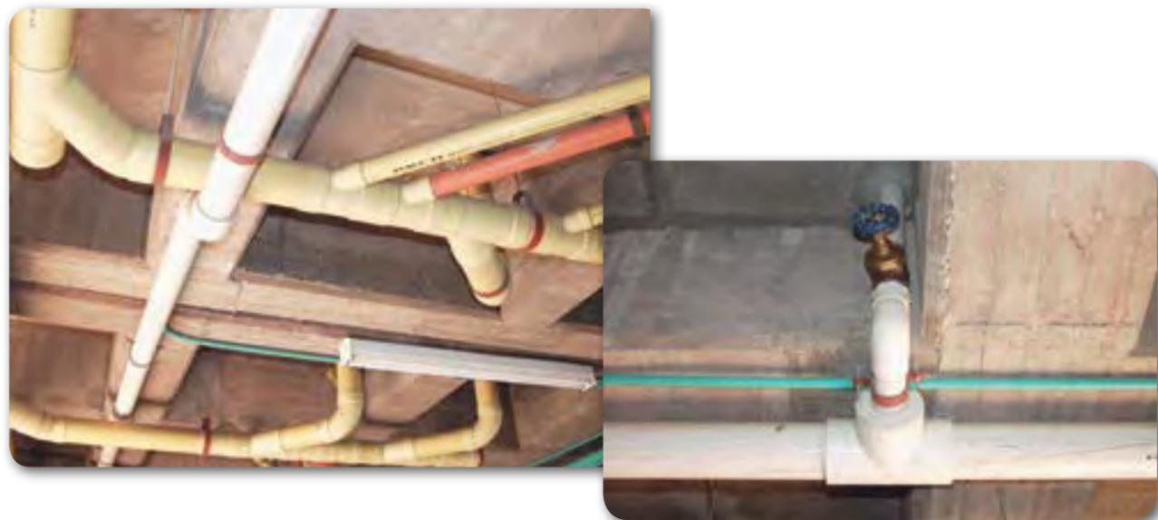
Los Tubosistemas PVC Presión de PAVCO son fabricados de PVC ( Policloruro de Vinilo).
