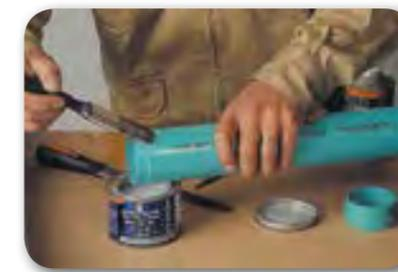
4. Limpie bien las superficies que se van a conectar tanto del tubo como del accesorio, con un trapo limpio humedecido en Limpiador Removedor PAVCO.
