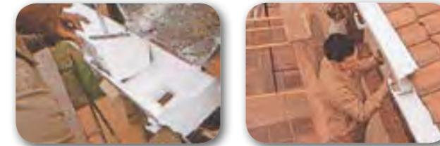
Inserte el borde de la canal en la aleta interna del accesorio.
