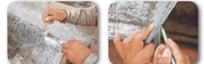
Coloque la manguera como indica la foto y haga marcas a la altura del nivel del agua.
