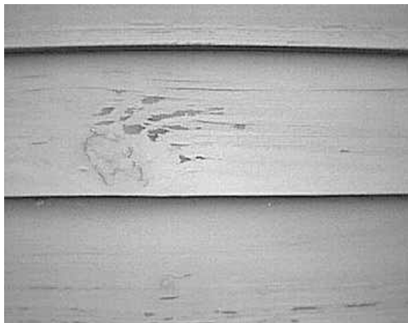
Figura 3. (a) Abertura ubicada en la cara norte de la vivienda, pintada con esmalte alquídico blanco brillante. Se observa un buen estado de conservación. Se muestra un nudo en el que comienza el deterioro de la madera. (b) Cara oeste donde se ve el mayor deterioro, incluso el desprendimiento de la capa de pintura.
