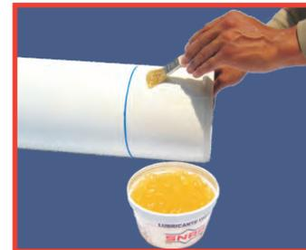
2. Aplique lubricante SNAP en el espigo del tubo a acoplar, colocándolo a la entrada de la campana.
