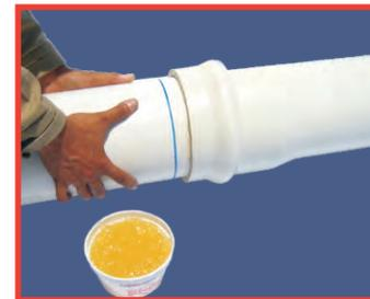
3. Inserte el espigo en la campana hasta la marca con un movimiento rápido. Si es necesario usar palanca, apóyela en un bloque de madera. El espigo debe tener un chaflán de 15°.
